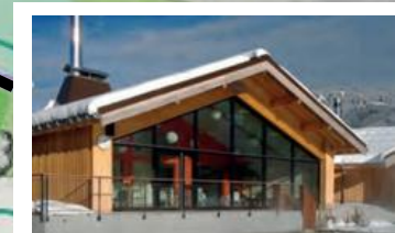
Nouveau bâtiment d'accueil
